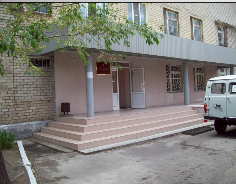
Центральное здание бюро
